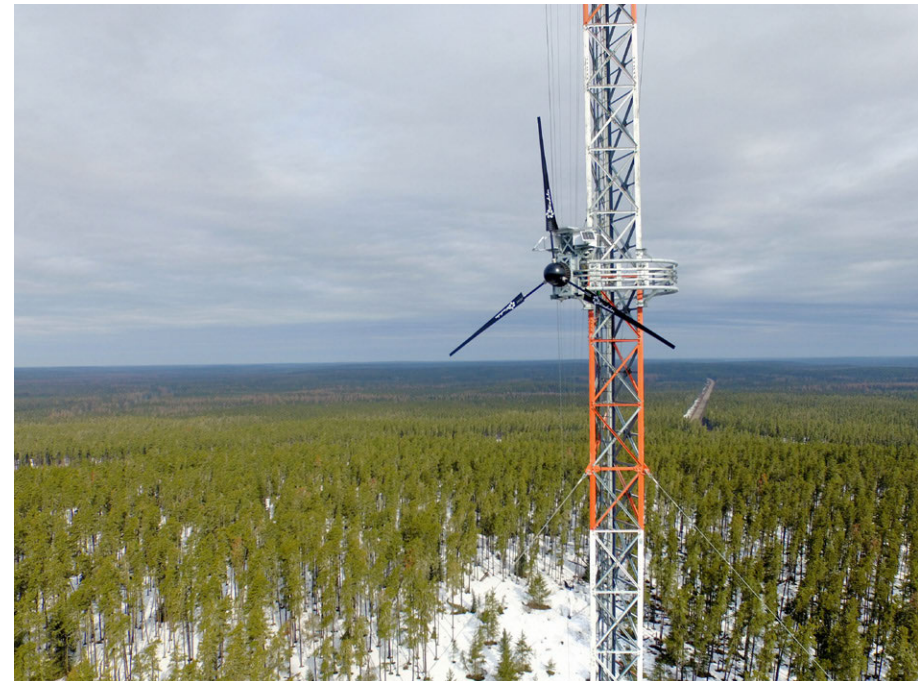
Systèmes hybrides d'énergie éolienne et solaire de pointe de Windular à la station cellulaire de Bell au lac Nungesser, en Ontario.
